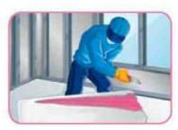
3.- Antes de abrir los paquetes colóquelos en el cuarto donde serán instalados. La manera de abrir el paquete es: cortando a lo largo con una navaja. El aislamiento viene comprimido, por lo que al abrirlo se expande. Cuide que tenga suficiente espacio.
